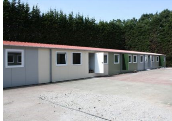
Wooncomplex Jobcenter in Den Haag Voorbeeld van onaantrekkelijk vormgegeven woonentrees
