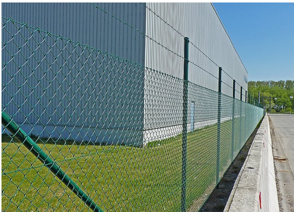
Voorbeeld van een hekwerk dat slecht past bij een woonfunctie
