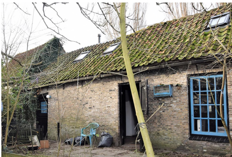
Figuur 1 - Foto woning
