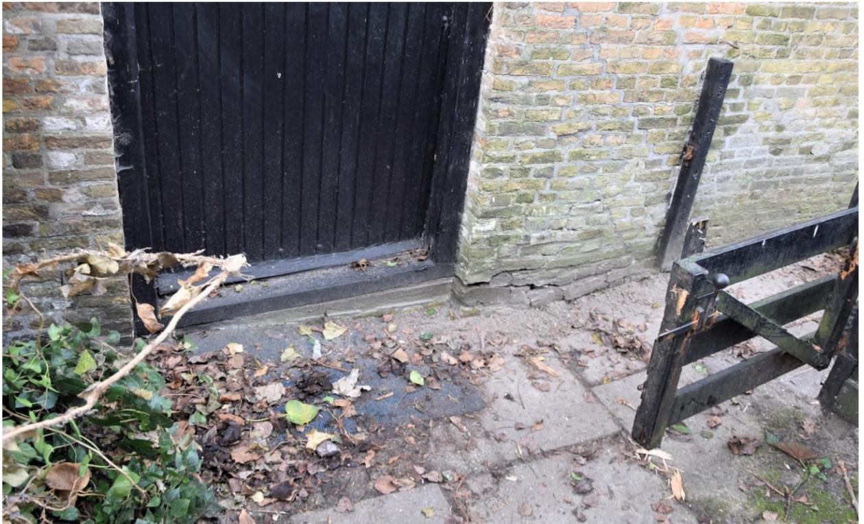
Gevelmetselwerk verbrijzeld.
