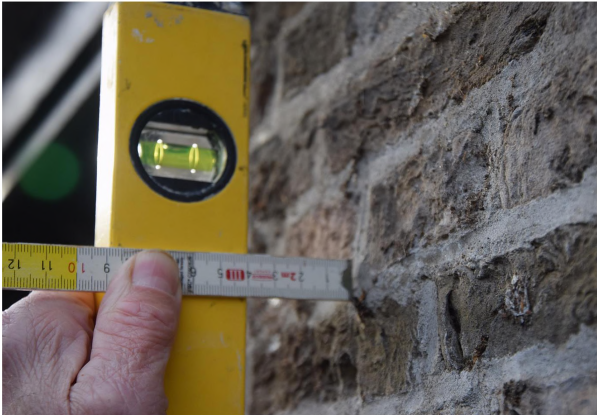
Scheefstand 4 cm/m 1 t.p.v. midden van de (voor)zijgevel.
