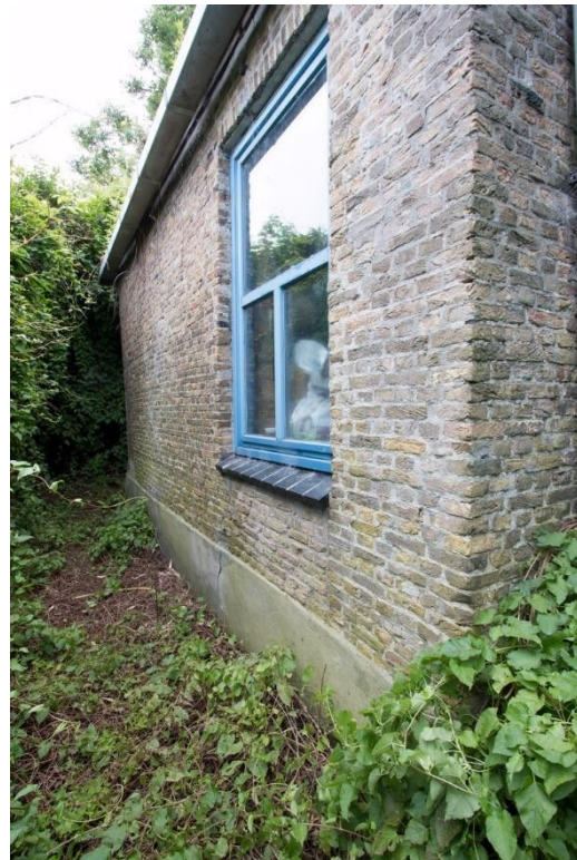
Aansluiting van de korte noordgevel op de oostgevel (met regenpijp) wijst op een faseverschil tussen beide gevels. Rechts is de aansluiting van de korte noordgevel (met venster) op de westgevel. Wanneer de goot wordt gevolgd, is goed te zien hoe de gevel uit buikt.
