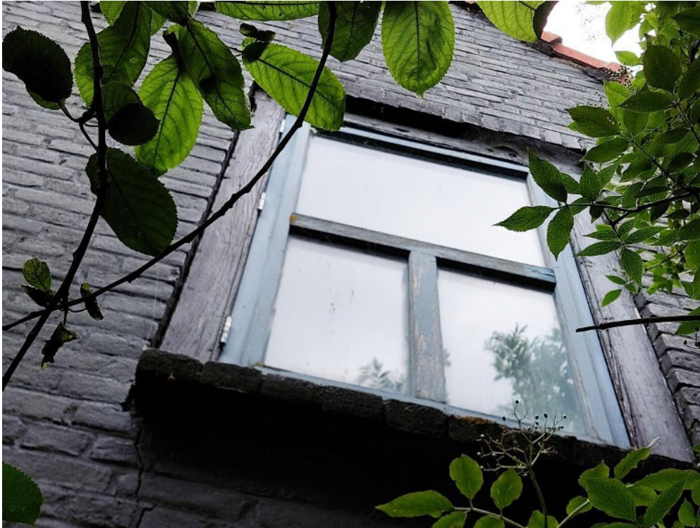
In de top van de gevel treffen we een kozijn aan dat vanwege profilering en bouwsporen nog als negentiende-eeuws (of zelfs laat achttiende-eeuws) kan worden aangemerkt. Het bevindt zich in een jongere gevel en bevat een nog veel jonger, in het kozijn geplaatst raam.
