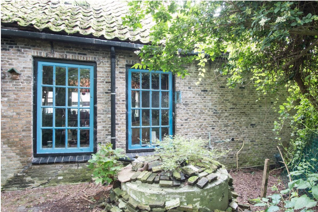
Zuiver gemetselde dagkanten , een aanwijzing dat de vensteropeningen van oudsher in het muurwerk aanwezig zijn. Doordat in de gevel bouw materiaal is hergebruikt, is het lastig om vast te stellen of het metselwerk nog terug is te voeren tot in de negentiende- of zelfs de late achttiende eeuw. Meest waarschijnlijk dateert zowel dit deel van het metselwerk als de set vensteropeningen uit de twintigste eeuw.
