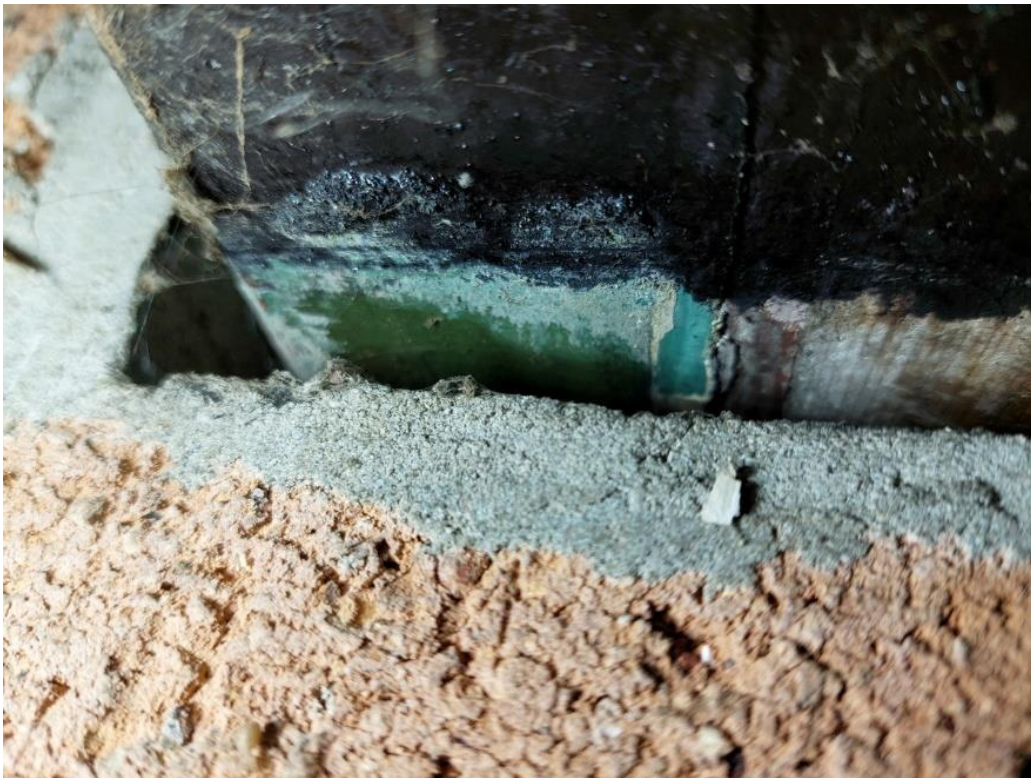
Ter plaatse van de porisowand tussen gang en toilet is groene verf op een zolderbalk te zien, wat aangeeft dat de wand onder een bestaande balk is opgetrokken óf de balk ten tijde van het metselen van de wand is hergebruikt.
