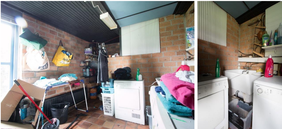
De bijkeuken met op de foto rechts nog een wastobbe uit de jaren zeventig. Vloerafwerking (plavuizen), wanden (Poriso) en plafonds (lattenplafonds) dateren ook uit die tijd.
