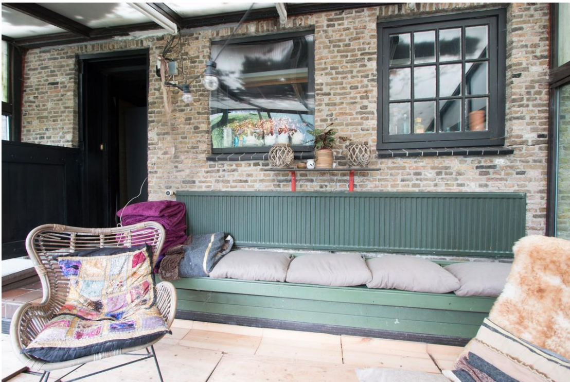
Deur- en vensteropening in de westgevel zijn secundair. Ze passen ook niet bij de schuurfunctie die dit deel van het gebouw langere tijd heeft gehad.
