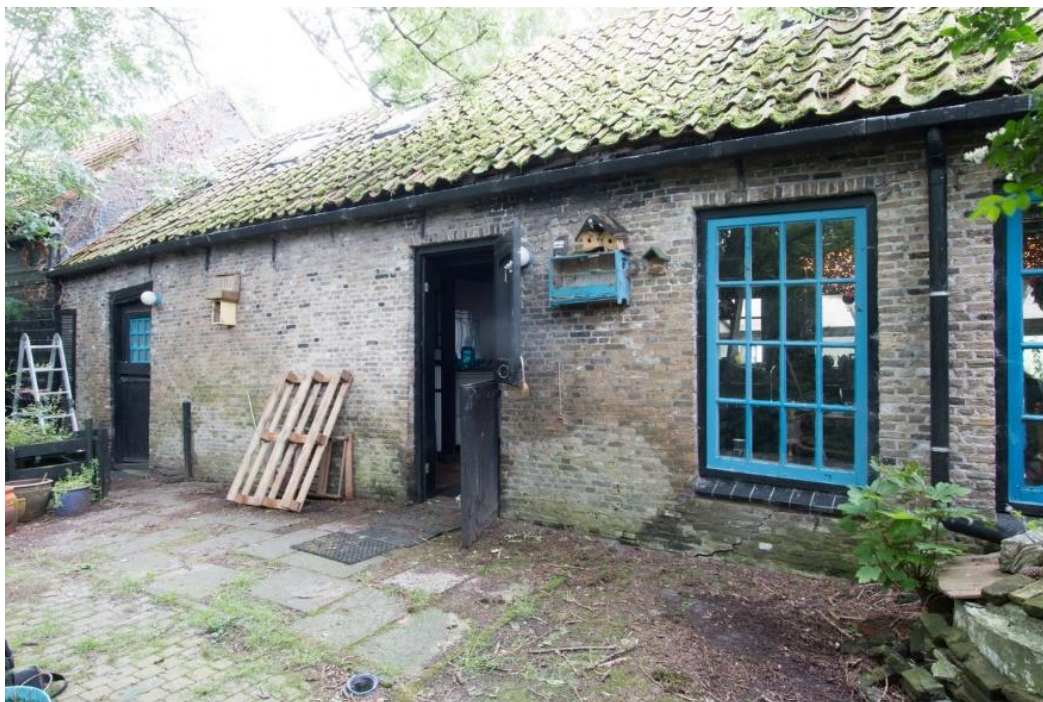
Deel van de lange oostgevel van het pand. Alle gevelelementen dateren uit de tweede helft van de twintigste eeuw. Er zijn tenminste twee fasen in het metselwerk te onderscheiden waarbij in ieder geval één fase sloopmateriaal is hergebruikt. De gevelindeling valt niet te rijmen met de functie van schuur die een deel het gebouw volgens een kadastrale veldtekening gehad heeft.
