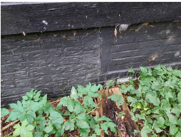
We zien jaren zeventig metselwerk aansluiten op de hoek die in de jaren twintig tot stand werd gebracht.
