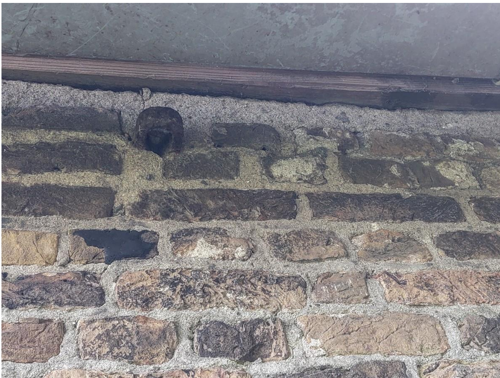
Er is een aanwijzing dat de kopgevel in het verleden wel eens een afgetopte topgevel kan zijn geweest, zoals het huis op het erf van de gesloopte bovenmolen op oude foto's. De knoop van het strijkbalkanker zit namelijk wel erg kort onder de muurplaat en de schieter is verdwenen.
