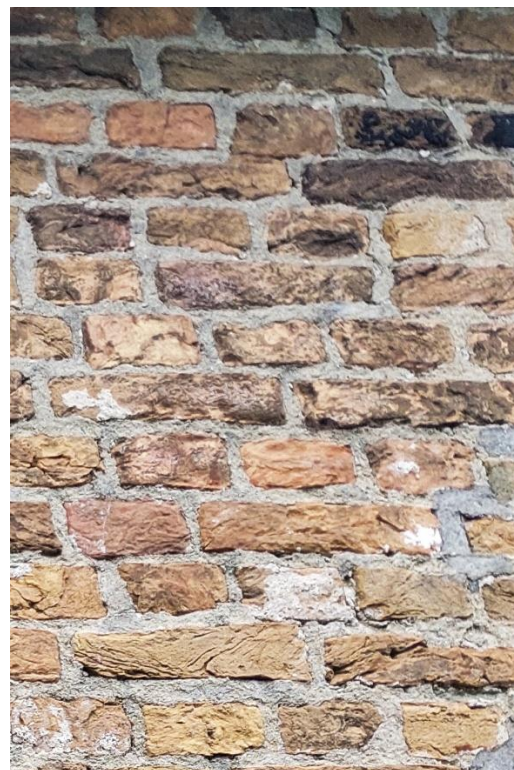
De dichtgezette gevelopening die normaliter met een kelderlicht in verband wordt gebracht. Op de rechterfoto restanten van pleisterwerk en beroete bakstenen, wat een aanwijzing is voor hergebruik van de baksteen bij het optrekken van de huidige gevel.
