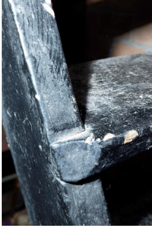
De hergebruikte trap in de gang. Op de rechterfoto detaillering van de treden met aansluiting op de trapboom wijst op een herkomst in de tweede helft van de negentiende eeuw.
