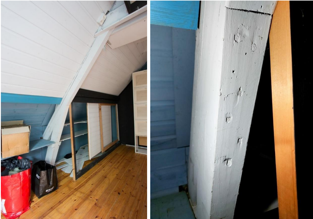
Details van het kaspant uit de jaren twintig. Rechts draadnagels in de kreupele stijlen.
