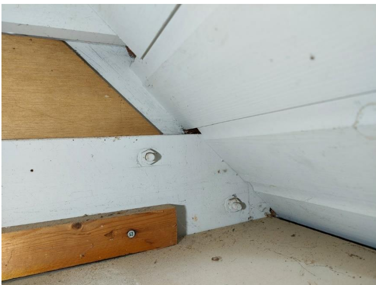
Verbinding van trekbalen met spantbenen door middel van bouten en moeren.
