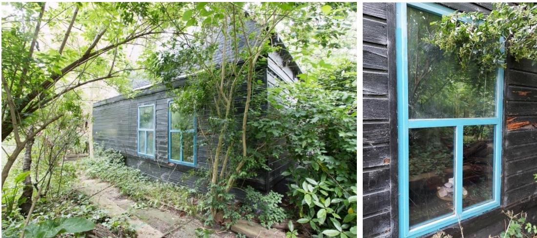
De gevels zijn op de begane grond vrijwel volledig verdwenen achter houten gevelbetimmering. Om een beeld te kunnen vormen van de gevels uit de jaren twintig, kan naar archieffoto's van de panden bij de fundamenten van de onder- en bovenmolen worden gekeken.
