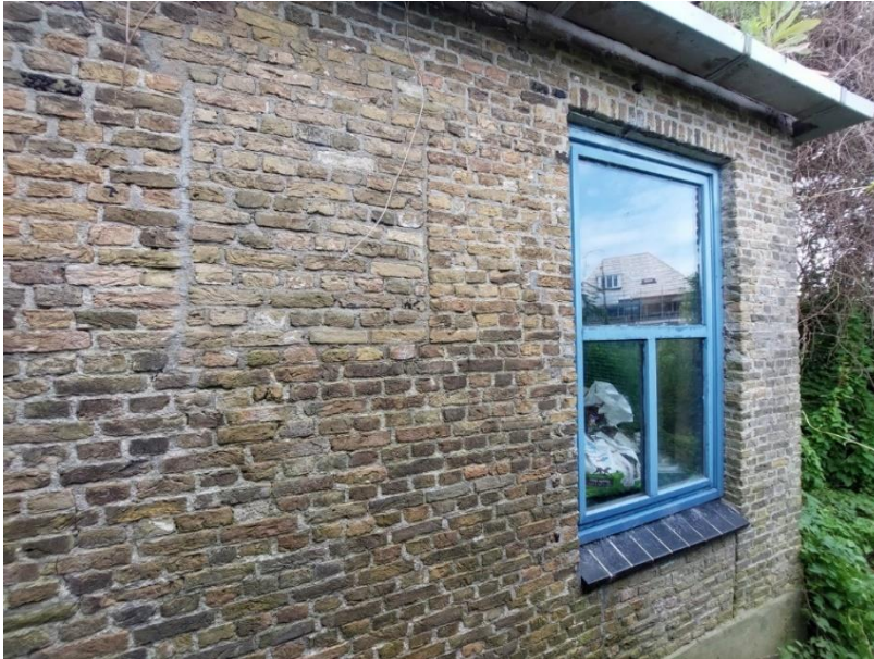
De dichtgezette, centrale vensteropening bevindt zich betrekkelijk hoog in de gevel. Die indeling correspondeert met de kopgevel van de boerderij die omstreeks 1930 bij de fundamente van de bovenmolen werd gebouwd.
